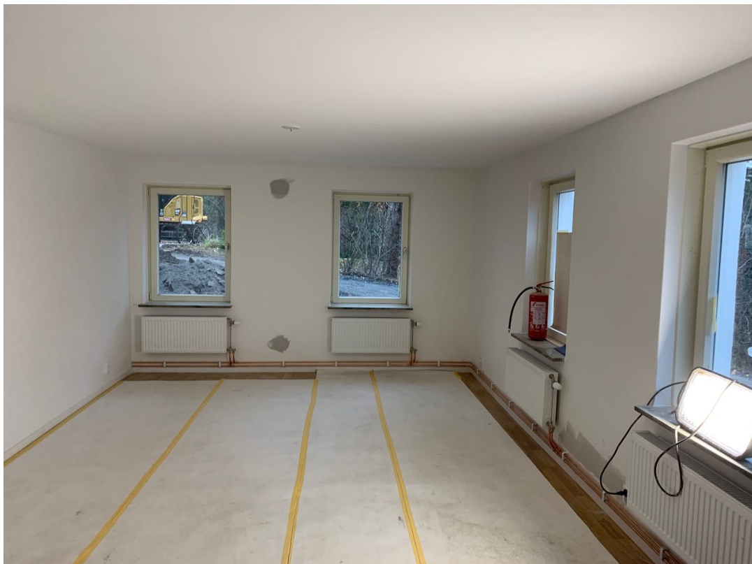
Byggarbetsplats. Vardagsrummet 2 november.
